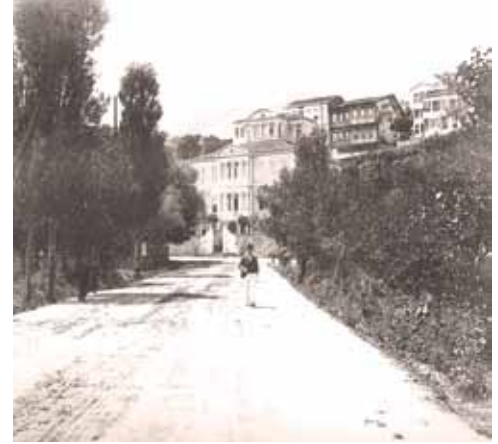
Yıkılmış olan Sigorta binasının yerinde bulunan otel
