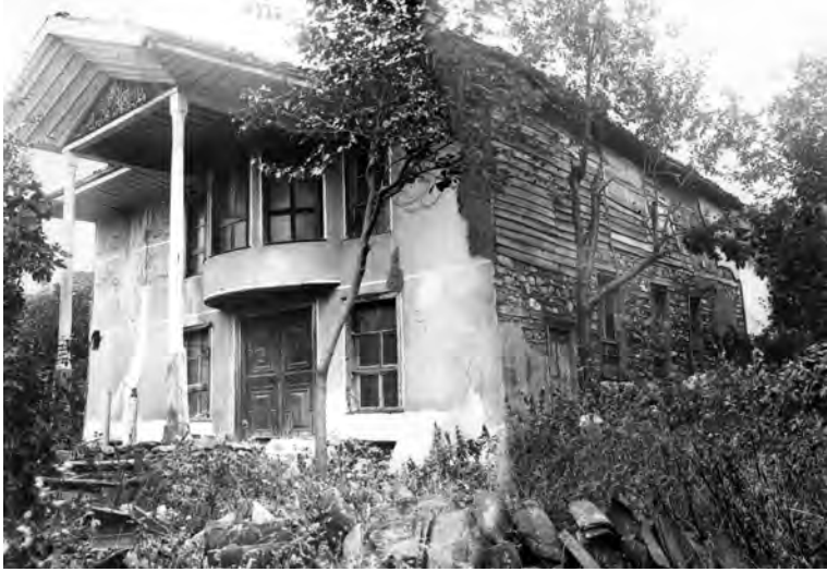
Bursa Mısırî Dergâhı (dıştan görünüş)
