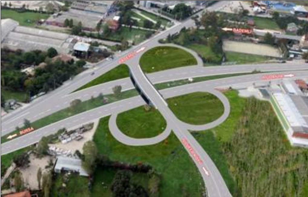
Yeni Yalova Yolu- Pınar Caddesi Köprülü Kavşağı (As-Merkez)
