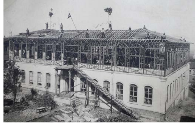
Taş binanın çatı onarımı, 1920'ler
