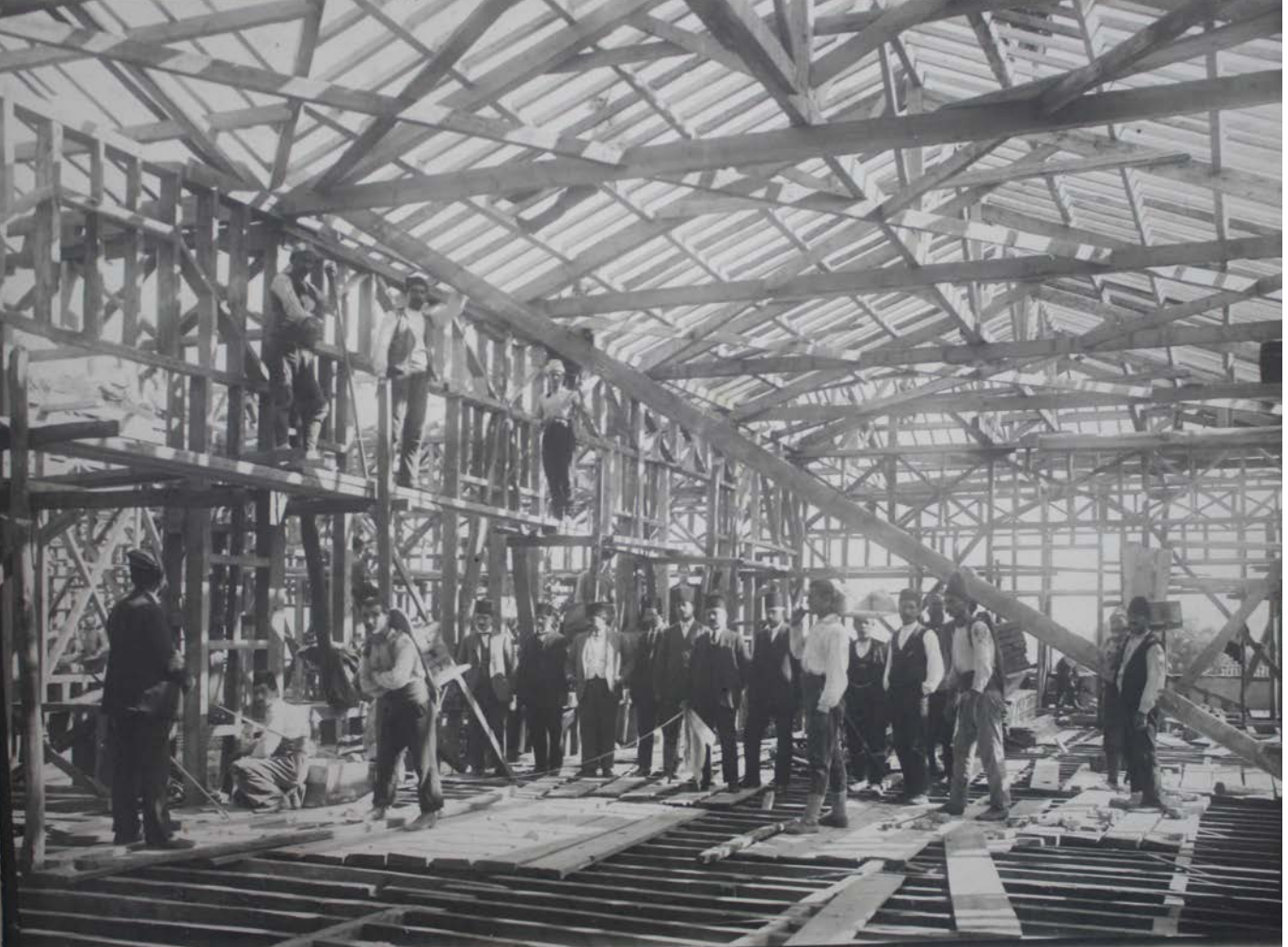
Taş binanın çatısının onarımı, 1920'ler
