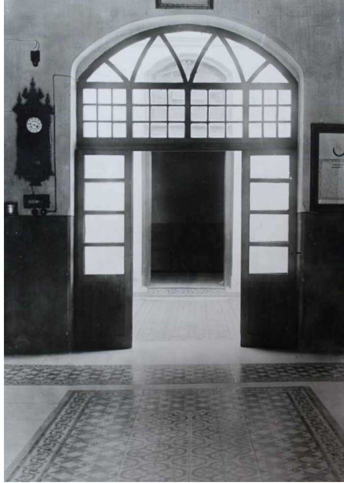
Yıkılan taş binanın giriş kapısı
