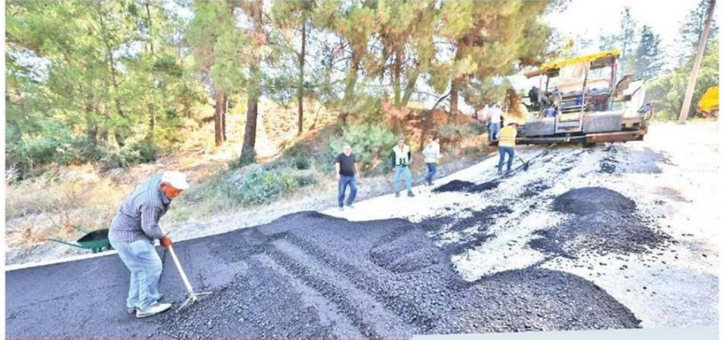
Ekipler, Orhaneli Karagöz Mesire Alanı yoluna tonlarca sıcak asfalt sererek güvenli ulaşımın altyapısını oluşturuyor.
