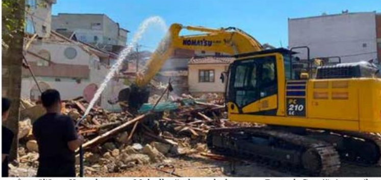
Inegöl'ün Kemalpaşa Mahallesi'nde bulunan Boşnak Camii'nin yenilen-
