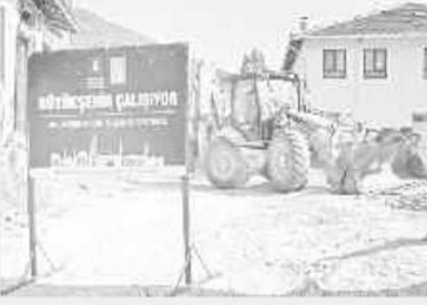
yon hattı ve 4 kilometrelik yağmur suyu hattı imalatı gerçekleştirdi. Büyükşehir Belediyesi BUSKİ Genel Müdür-
