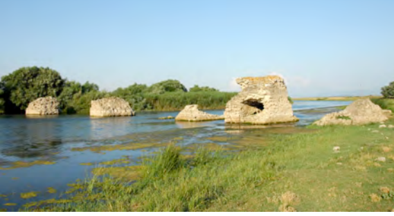
Şekil 80. Uluabat köyü yakınındaki köprü Figure 80. Bridge of Uluabat
