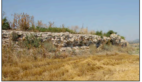
Şekil 85. Yenikaraağaç Kaleler'deki Bizans Suru Figure 85. Byzantine fortification in Kaleler
