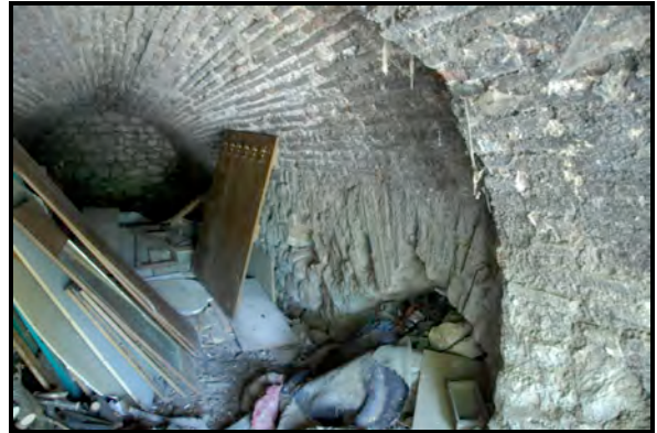
Şekil 36. Tahtalı'daki Tonozlu Mekan Figure 36. Vaulted building in Tahtalı
