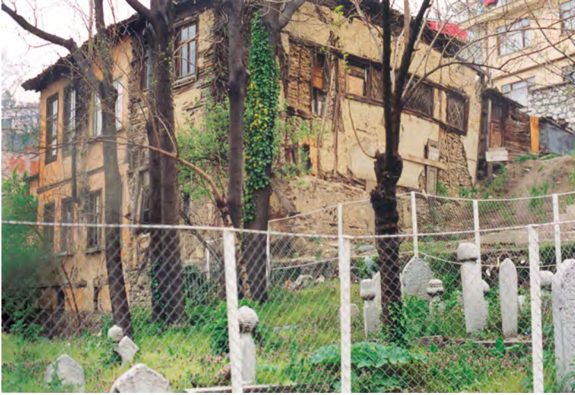
Seyyid Usûl Dergâhı ve hazîresinin restorasyon öncesi görü- nümü
