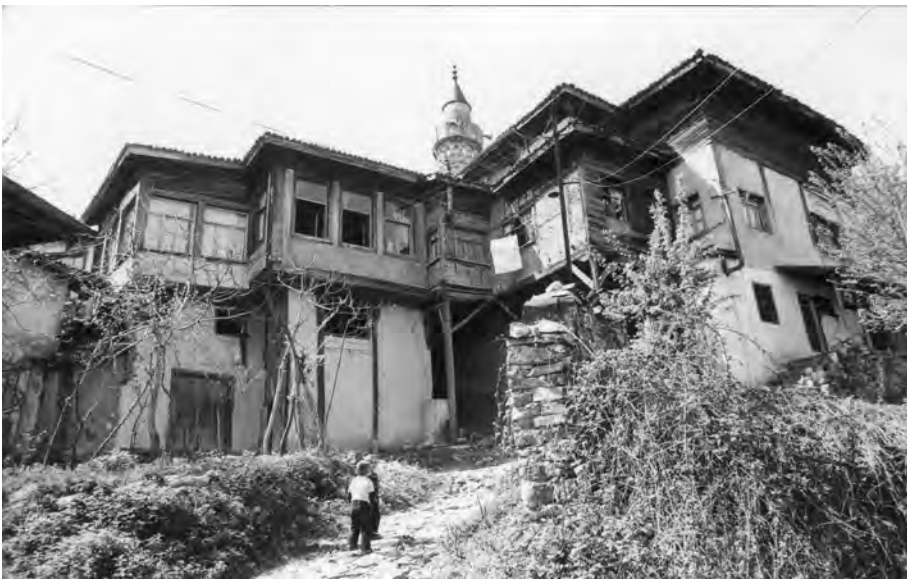
Üftâde Tekkesi'nin onarımdan önceki görünümü
