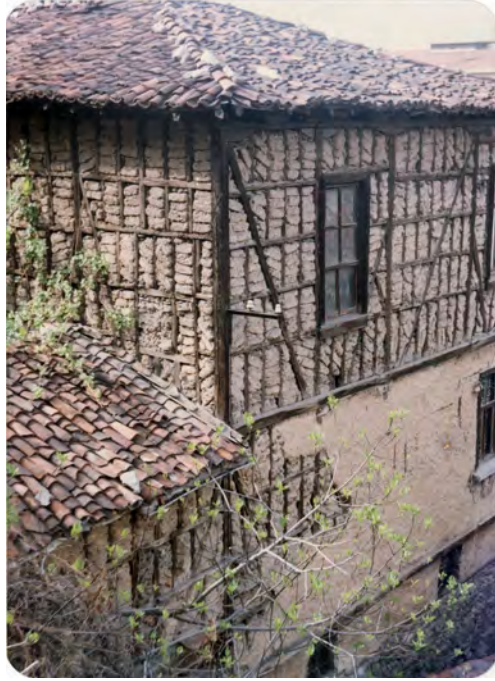
Restorasyon öncesi Seyyid Usûl Dergâhı harem binası. (MKA)
