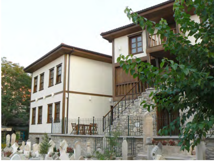
Seyyid Usûl Dergâhının restore edildikten sonraki hali
