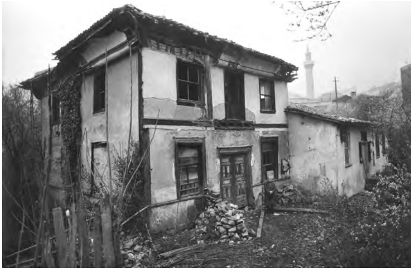
Karabaş-ı Veli Dergâ- hı'nın resto- rasyondan önceki hali
