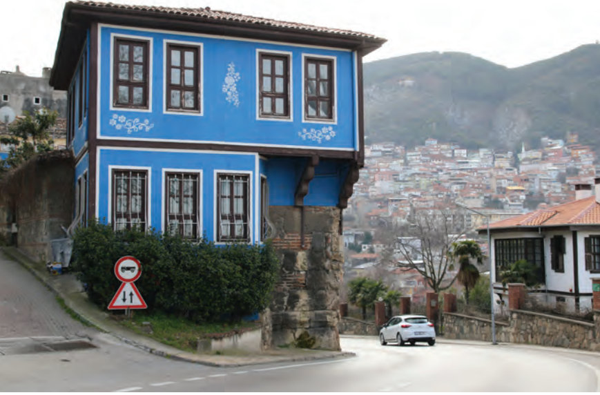
Bir zamanlar kaplıca kapısının bulunduğu yol
