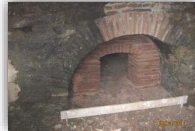
Onarım sırasında külhan...
