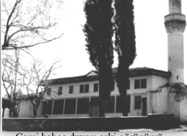
Cami bahçe duvarı eski görünümü...
