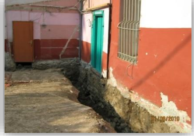
Cami çevresi drenaj kazı başlangıcı...
