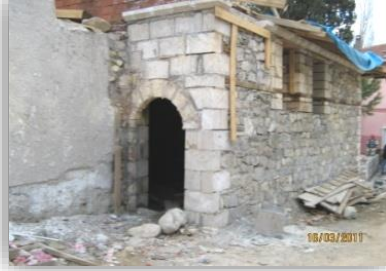
Giriş kapısı-soğukluk yenileme...
