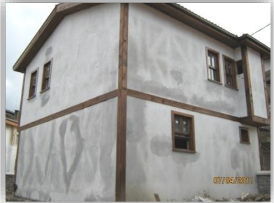
İmam Evi doğramalarının montajı...
