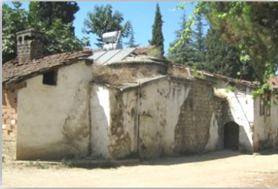
Aksu Köyü hamamı dış görünümü.
