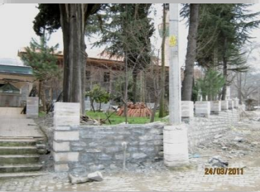
Cami bahçesi duvar çalışmaları...
