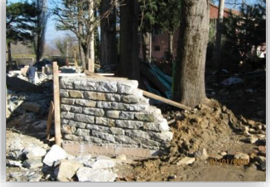
Cami bahçe duvarı taş işçiliği...
