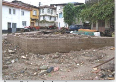
İmam Evi temel çalışmaları...
