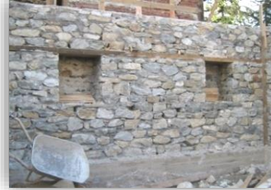
Soğukluk iç mekân inşaatı...
