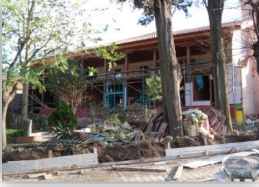
Yeni bahçe duvarı temel çalışmaları...
