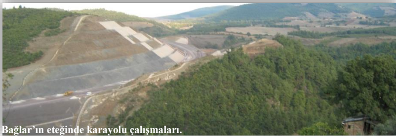
Bağlar'ın eteğinde karayolu çalışmaları.
