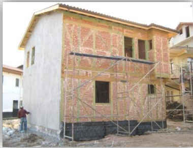
İmam Evi sıva çalışmaları...
