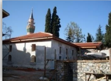
Çatı ve dış sıvanın tamamen yenilenmesi...
