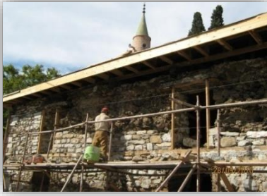
Sıvalar kazınıp duvarlar kısmen örüldü...
