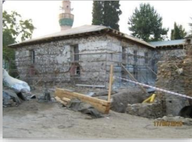
Cami dış sıvalarının kazınması...
