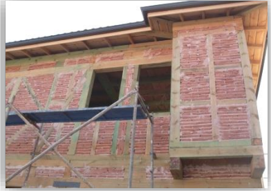
İmam Evi duvar dolgu çalışmaları...
