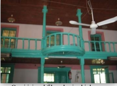
Cami içi mahfil cephesi eski durumu...
