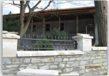
Bahçe duvarı aksesuar çalışmaları...
