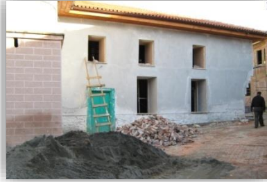
Duvar onarımı sonrası sıva...
