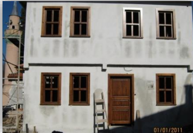
İmam Evinin dış cephe görünümü...
