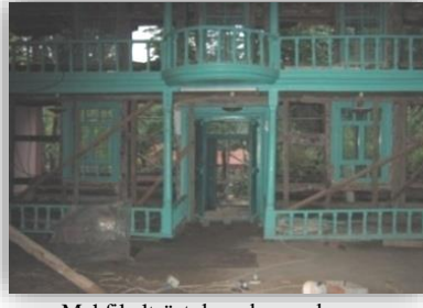
Mahfil alt-üst duvarların yıkımı...
