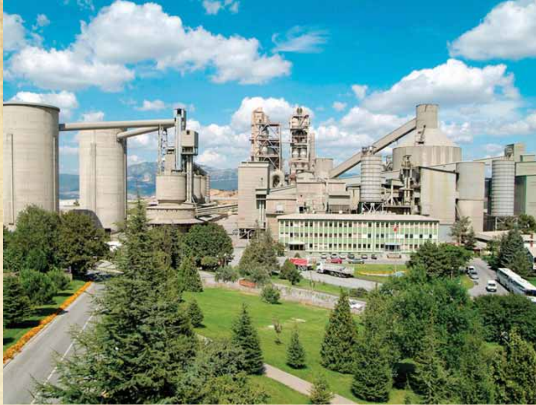
Bursa Çimento Fabrikası (Bursa Çimento Arşivi)
