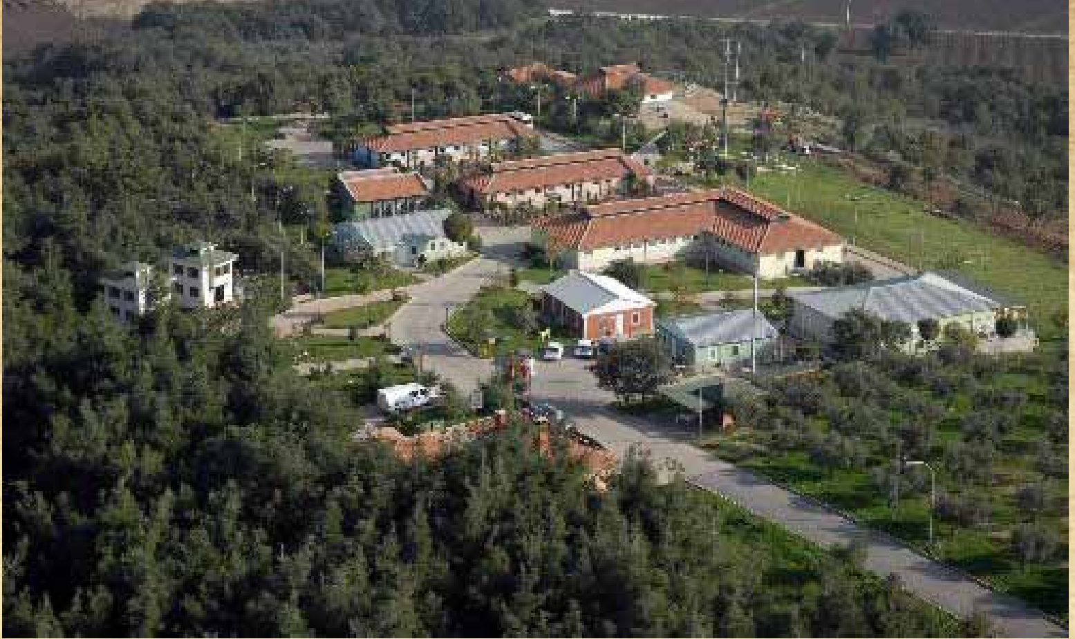
Sahipsiz Hayvanlar Barınağı (Osmangazi Belediyesi Arşivi)
