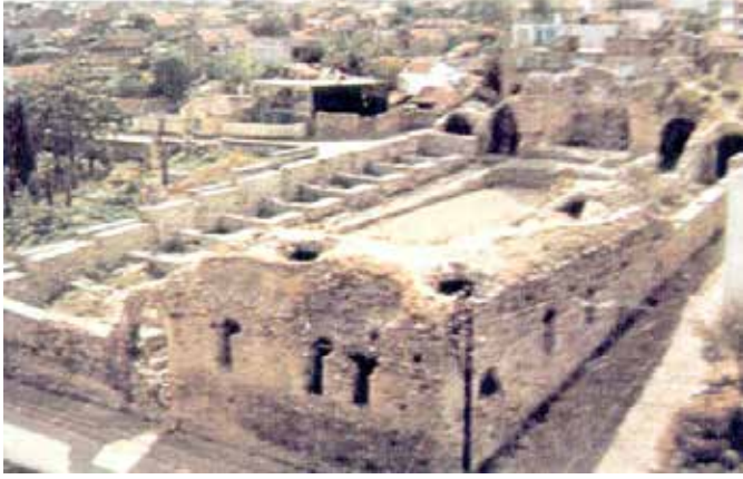
Yıldırım Darüşşifası onarımdan önce önce genel görünüşü
