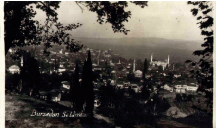
Bursanın güney-doğudan umumi görünüşü
