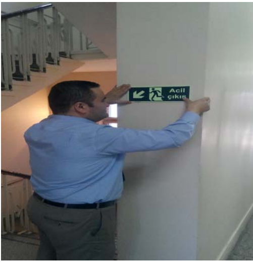
ACİL ÇIKIŞ YÖNLENDİRME LEVHASI MONTAJI - ELEKTRİK TESİSAT KONTOLÜ
