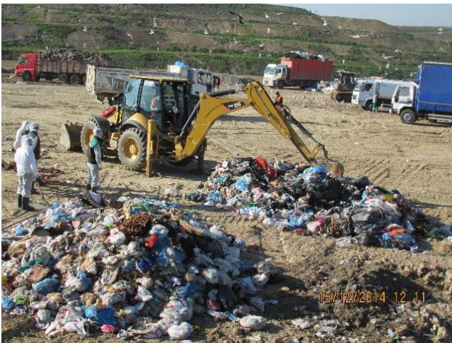
Fotoğraf 6-2 Belirlenen bölgelerden gelen atığın boşaltılması ve keçe ile karıştırılması
