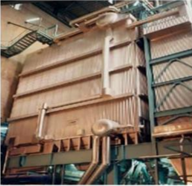
Şekil 10-8 Buhar kazanı örneği
