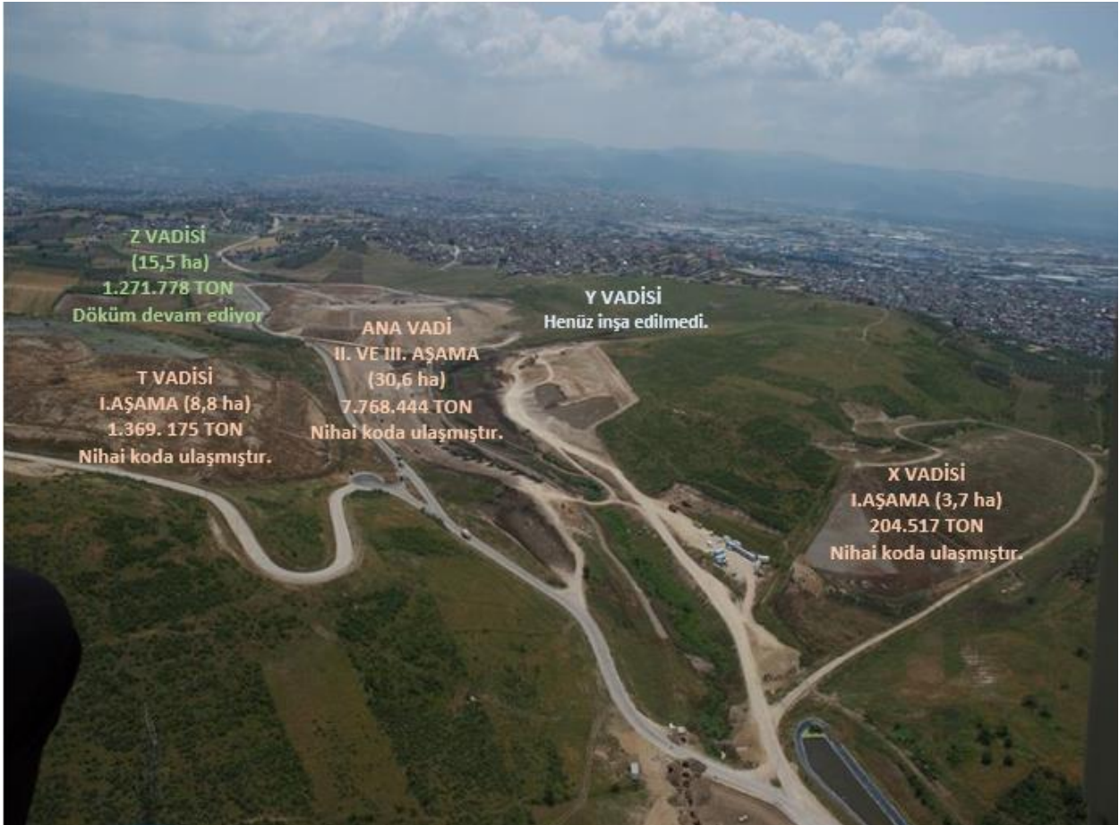
Şekil 3-5 Yenikent Katı Atık Düzenli Depolama Sahası, 2014
